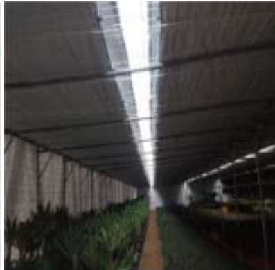
에너지절감시설 설치 (다겹보온커튼 설치)
