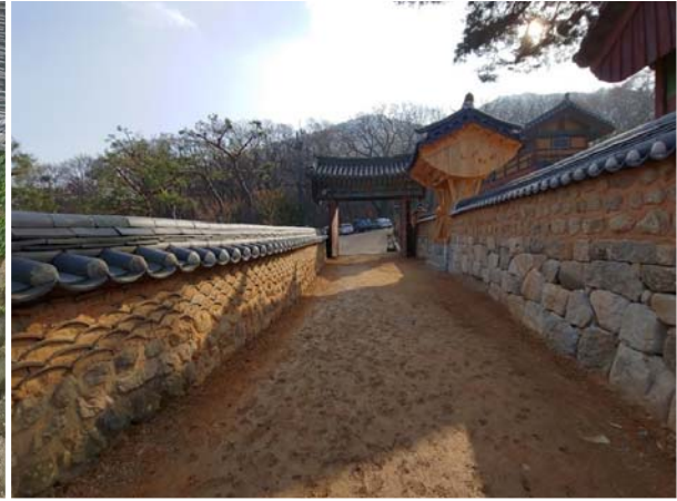
진여문 주변담장 정비 3(후)
