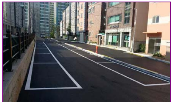
소규모 공동주차장 건설
