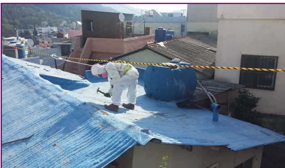
노후슬레이트 지붕 철거
