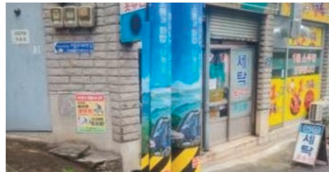
전봇대 광고물부착 방지판 설치
