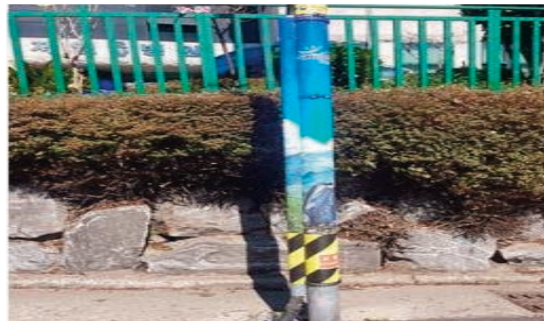
서부로 일원 방지판 설치 후
