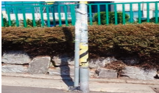
서부로 일원 방지판 설치 전
