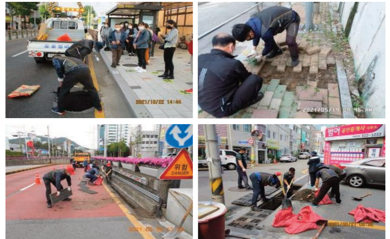
도로 보수 및 준설 작업
