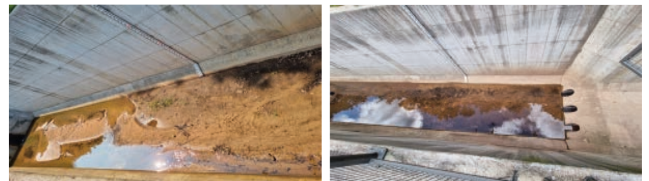
침사지 준설 전
