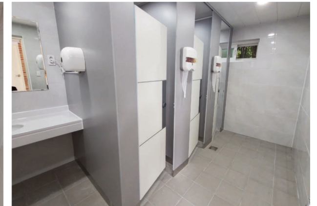
놀이마당공원 화장실 정비 후
