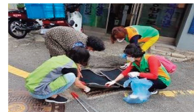
제12호 태풍 오미이스 대비 배수로 덮개 정비
